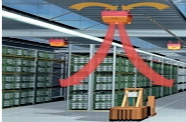
Abb. 4. Luftverteilung mit den Lufteinspritzdüsen in den Flach- und Hochregallagern (*Jak wydajne ogrzewać magazyny wysokiego składowania z wykorzystaniem zdecentralizowanych modułów wentylacyjnych?*, 2015, retrieved from: <http://www.hoval.pl/uslugi/blog/jak-wydajne-ogrzewac-magazyny-wysokiego-skladowania-z-wykorzystaniem-zdecentralizowanych-modulow-wentylacyjnych>)
